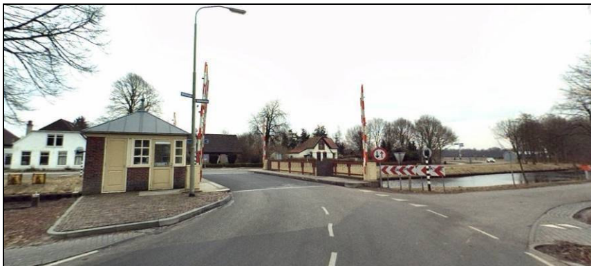
Figuur 4.27: Brug over de Drentsche Hoofdvaart te Norgerbrug (bron: CycloMedia)
