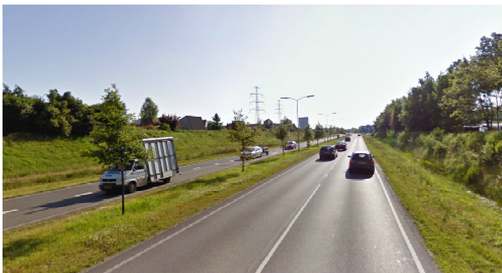
Figuur 18. Foto Balkenweg (N371) (Bron: Google)
