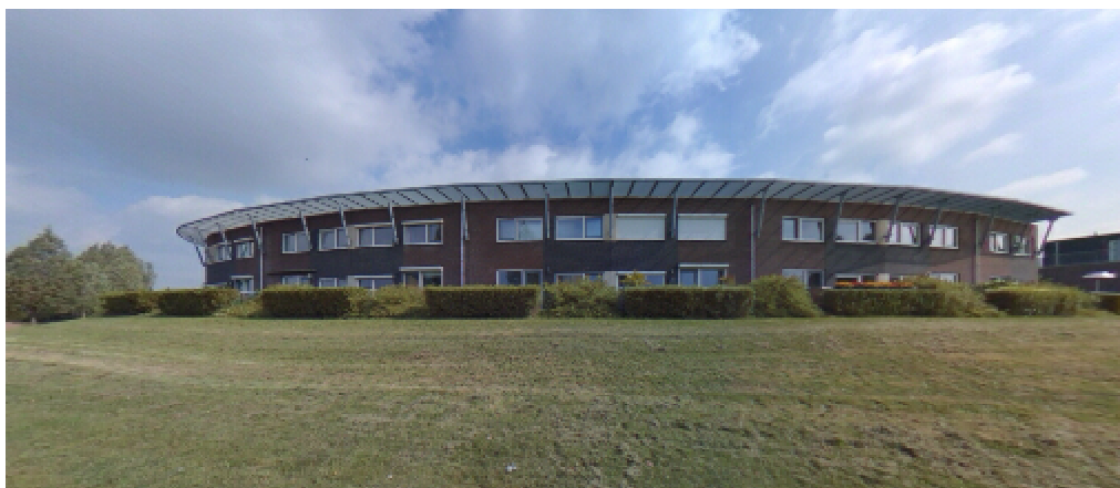
Figuur 34. foto woningen Kersenhof
