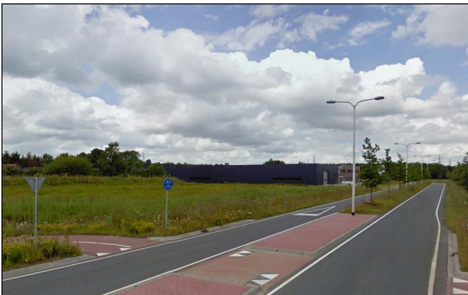
Figuur 15. Combi-Drain vanaf de Maria Montessoriweg (bron: Google Earth)
