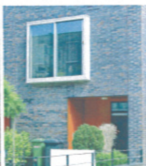
Reliëf in de gevel met behulp van opvallende raamconstructies
