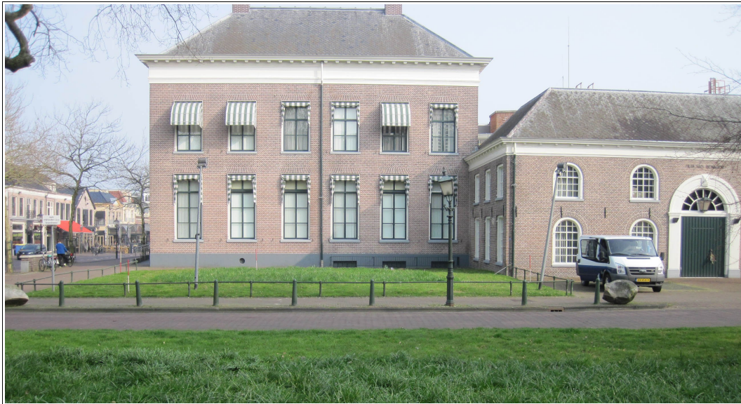
Figuur 2: Assen, Brink 9: foto genomen in noordelijke richting. Midden op de foto staat het gerechtsgebouw, rechts het huis van bewaring. Het plangebied is het grasveld voor het gerechtsgebouw en de parkeerplaats rechts ervan die loopt tot aan de grote deur van het huis van bewaring.
