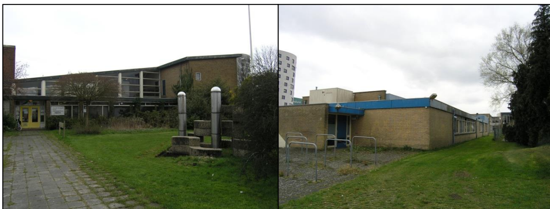
Figuur 1. Impressie te slopen bebouwing (6 april 2016)
