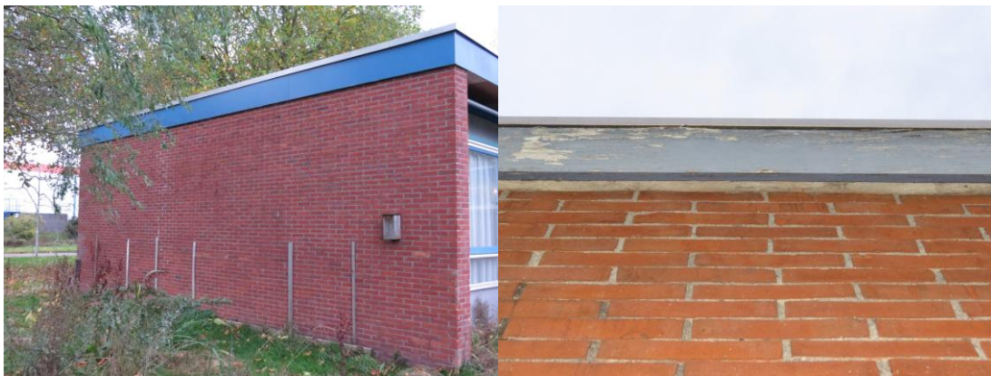
Foto 3 en 4. Spouwmuur zonder stootvoegen en ventilatieopeningen en een voorbeeld van sluitende boeidelen en daklijsten (foto's A&W 2014).
