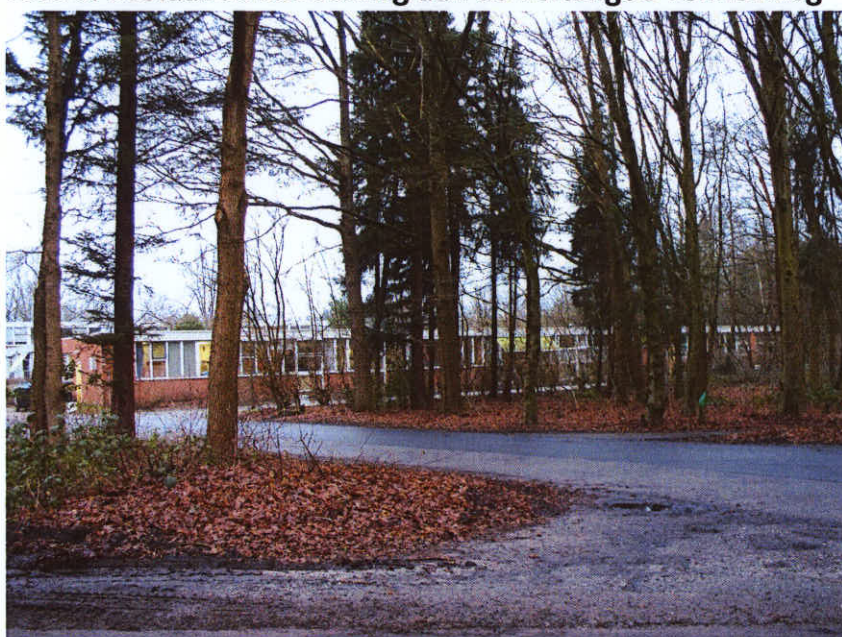
Foto 6: bestaande bebouwing aan de Verlengde Vennenweg
