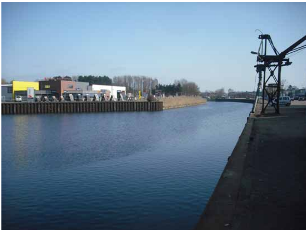
Het Havenkanaal nabij kruising met Stadsboulevard (in oostelijke richting gezien)
