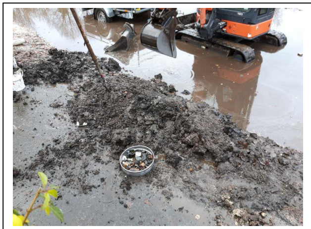
Foto 5. Opgegraven materiaal asbestinspectiegat GA13
