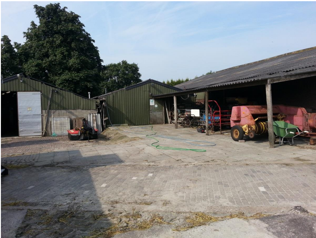
Figuur 3 te slopen bebouwing t.b.v nieuwbouw
