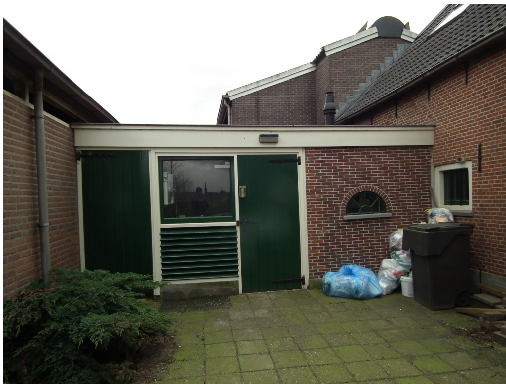
Figuur 3 Aan de blijvende bebouwing zijn verschillende nesten aangetroffen van boerenwaluw, ook is het aannemelijk dat hier huismus en mogelijk ook gierzwaluw broedt.
