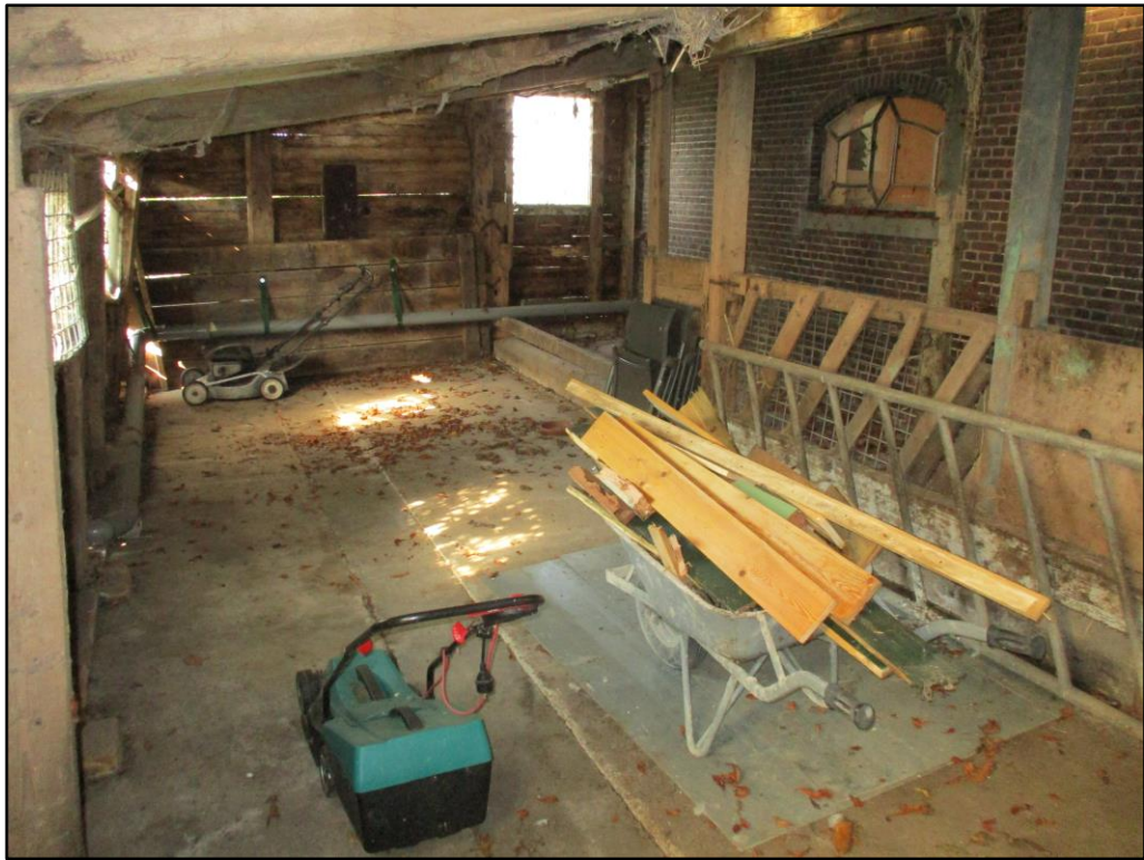
Figuur 3 Binnenzijde van de schapenstal op de planlocatie.
