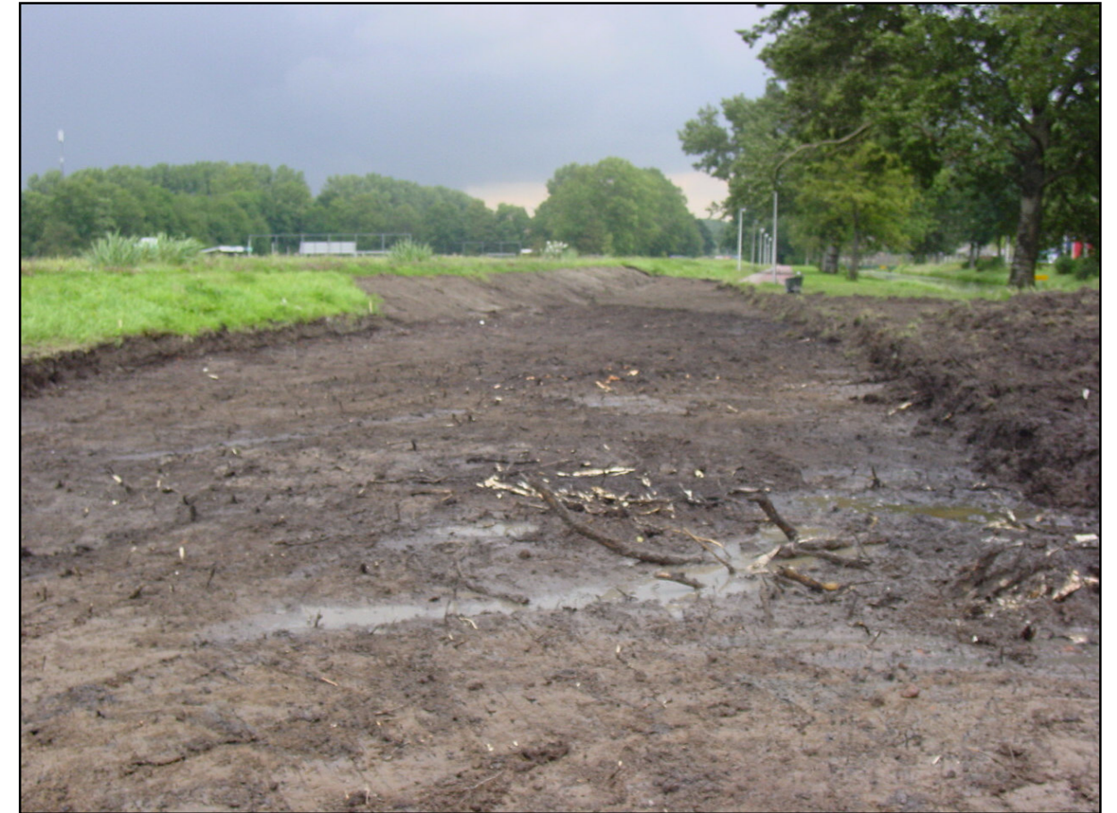
Figuur 3. Ontgraving achter de dijk ter hoogte van het kasteel.
