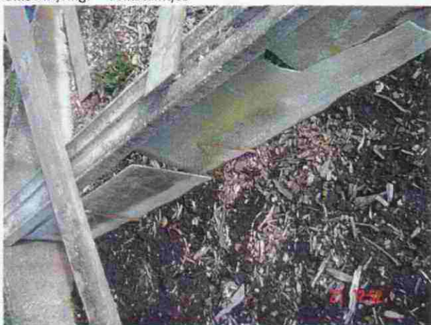
Fotonummer: 15 Omschrijving: Asbestverdacht materiaal volkstuintjes
