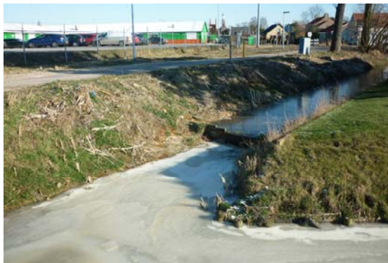
Figuur8: huidige stuw in het watersysteem
