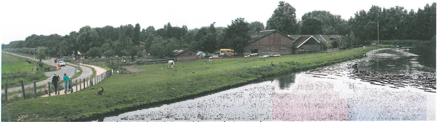
uitzicht over open talud maar ook op veel gesloten achterwanden van schuren
