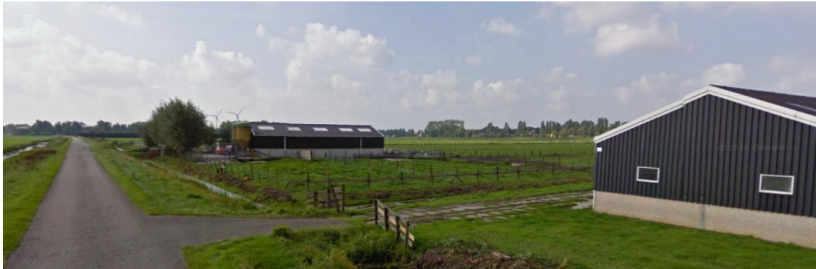
Figuur 4 Schuur planlocatie en schuur ten oosten
