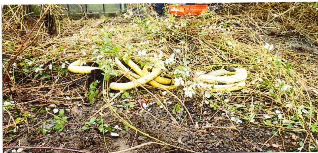
RE 1 verwijderen bramen en afzetten houtopstanden
