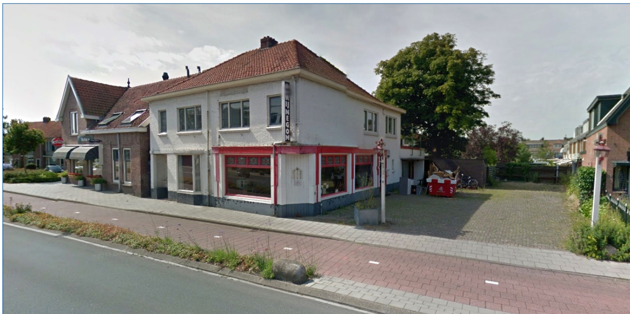
Figuur 3. De voormalige bebouwing in het plangebied, Café Rijnegom (bron: Google Streetview).
