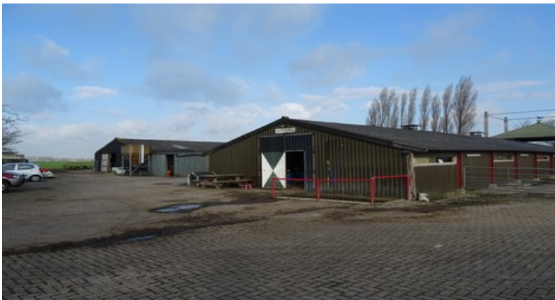
Twee te slopen schuren in het plangebied
