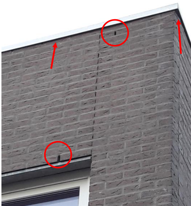
Figuur 4.1 Potentiële verblijfplaatsen vleermuizen in de vorm van open stootvoegen en ruimte achter daktrim.
