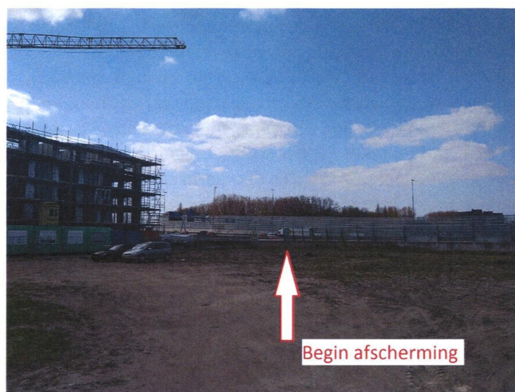
Figuur 5: Afscherming naast appartementen in aanbouw
