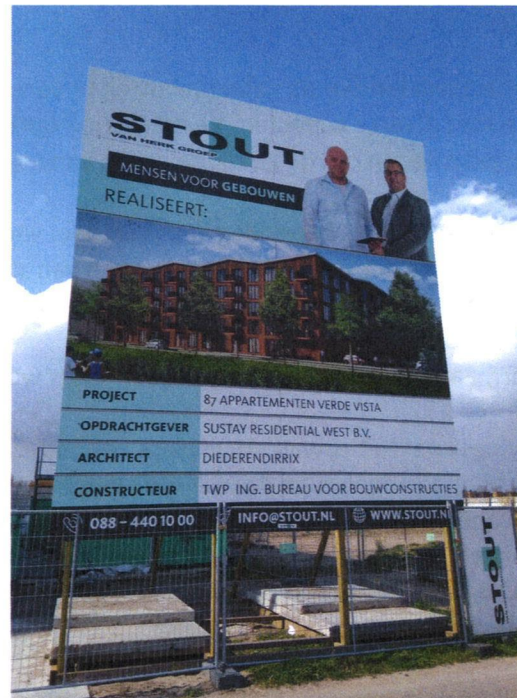
Figuur 2: Woningen in aanbouw april 2019
