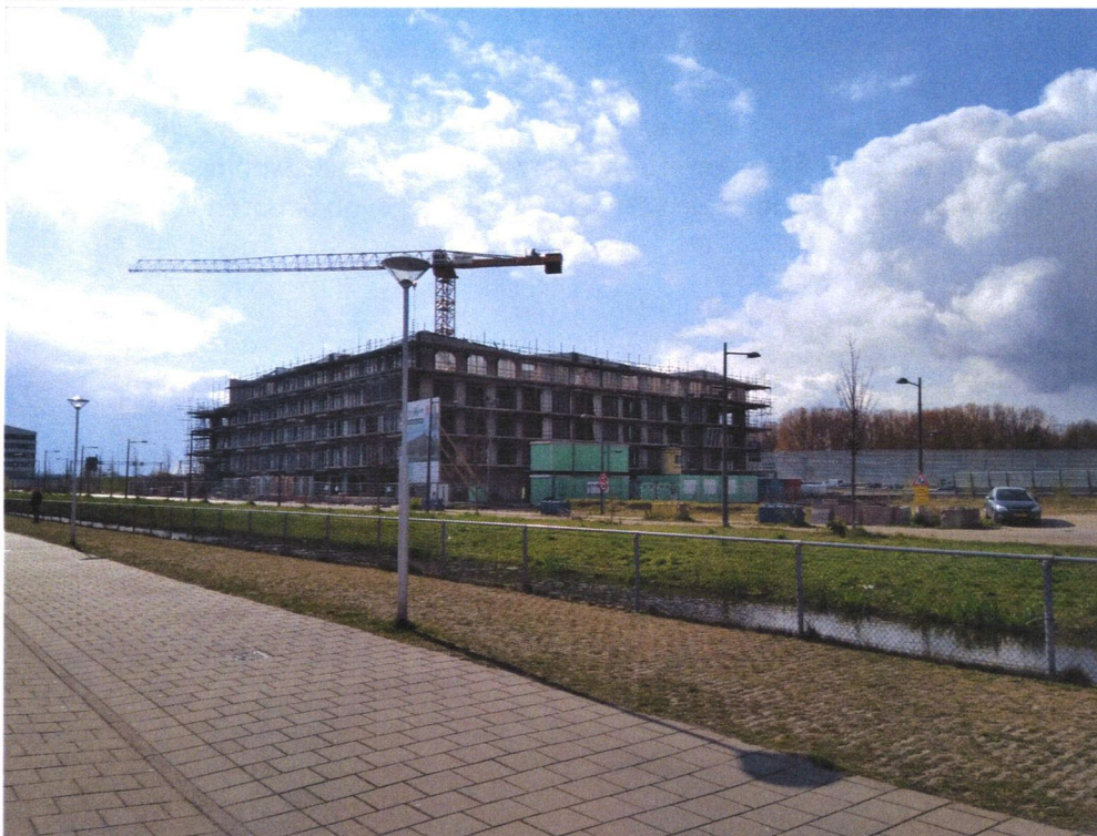
Figuur 1: Woningen in aanbouw april 2019
