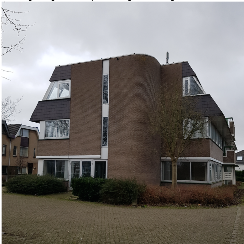
Afbeelding 7. Het gebouw met open stootvoegen en schuine gevels.
