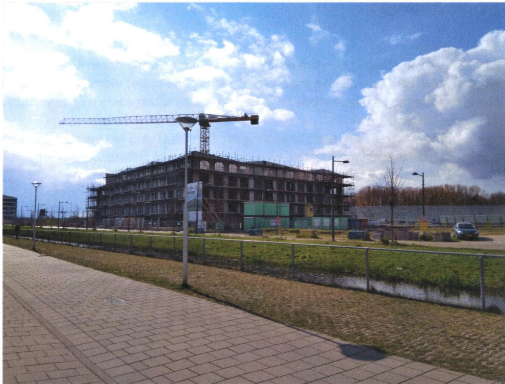
Figuur 1: Woningen in aanbouw april 2019
