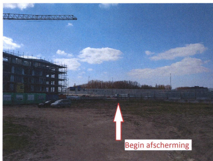
Figuur 5: Afscherming naast appartementen in aanbouw
