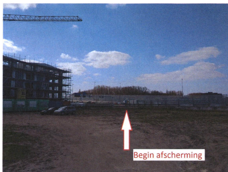
Figuur 5: Afscherming naast appartementen in aanbouw
