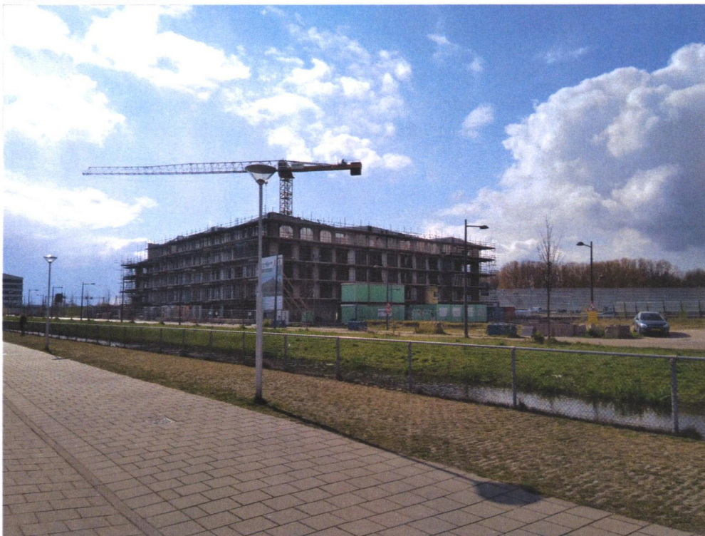
Figuur 1: Woningen in aanbouw april 2019
