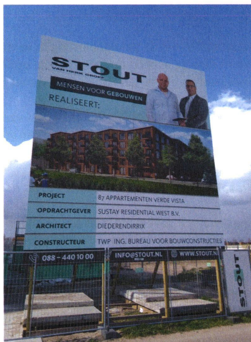
Figuur 2: Woningen in aanbouw april 2019
