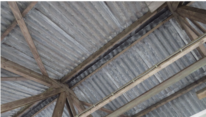
Afbeelding 11: Dak van schuur: ongeschikt voor vleermuizen.
