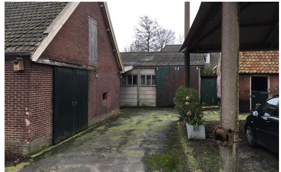
Bestaande bebouwing, stal met hooiberg
