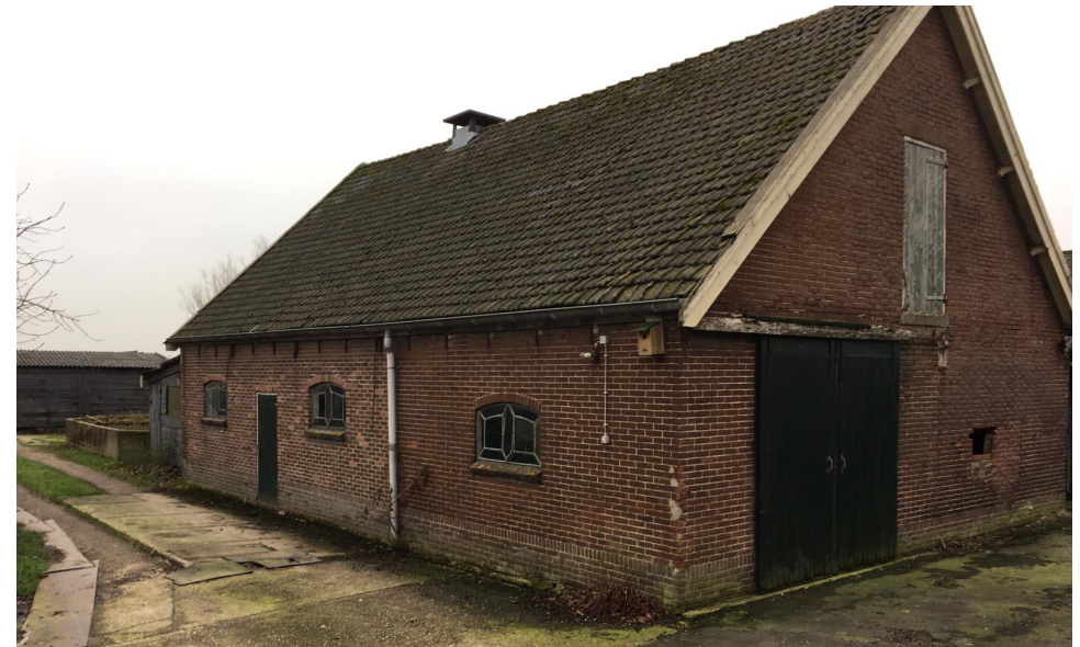
Bestaande stal wordt gerestaureerd
