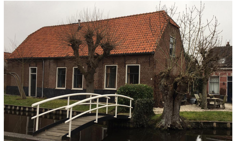
Bestaande boerderij gezien vanaf 't Watertje
