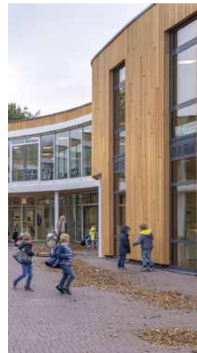
Verticale geleding in de gevel
