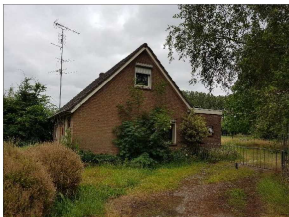
Figuur 3. Woonhuis op perceel
