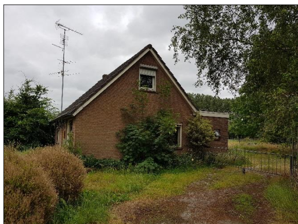
Figuur 3. Woonhuis op perceel.
