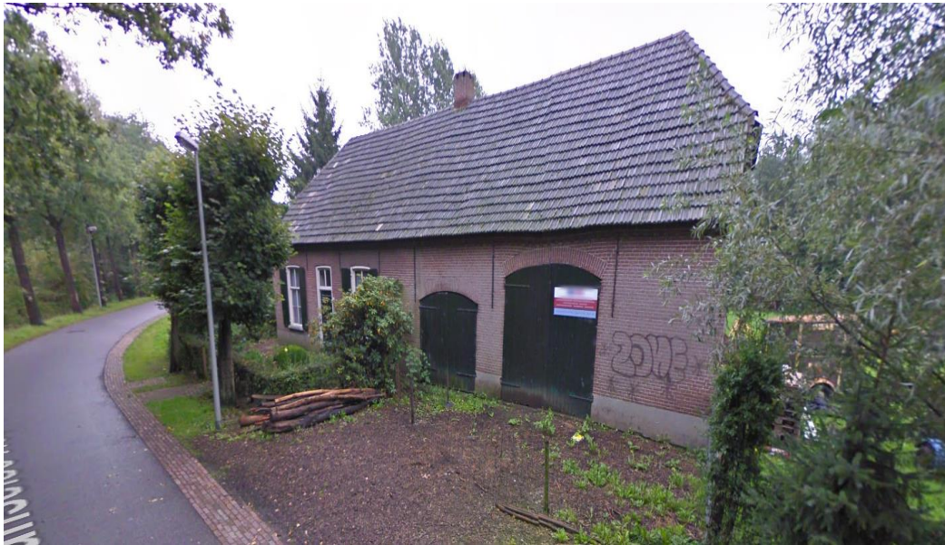
Figuur 2.1; bestaande woning plangebied aan de Munselse Hoeve
