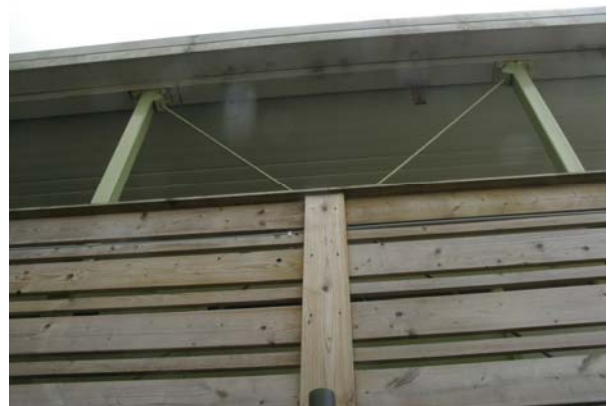
Detail potentiële verblijfplaats
