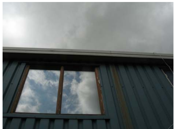
Gebouw detail, opening niet toegankelijk
