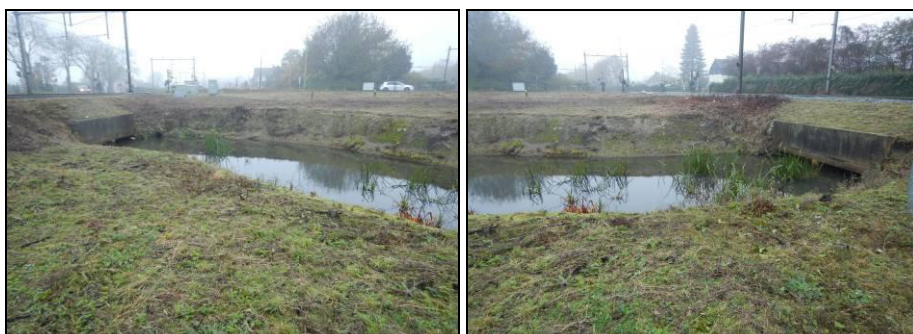
Het deel tussen de twee sporen met watergang op de voorgrond en Tongersestraat op de achtergrond.
