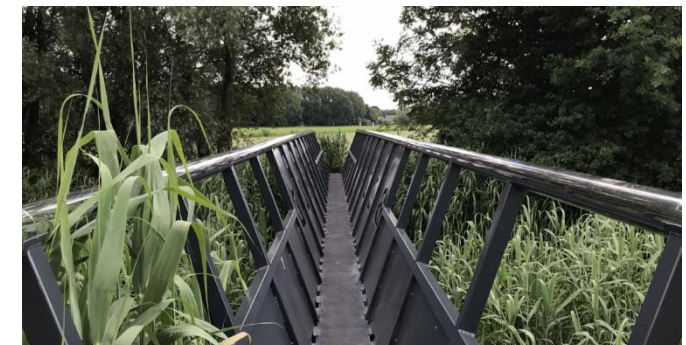
Figuur 126: brug over de Beerze
