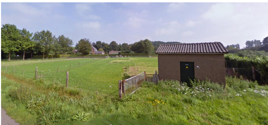
Figuur 3. Elektriciteitshuisje ten noorden van het plangebied
