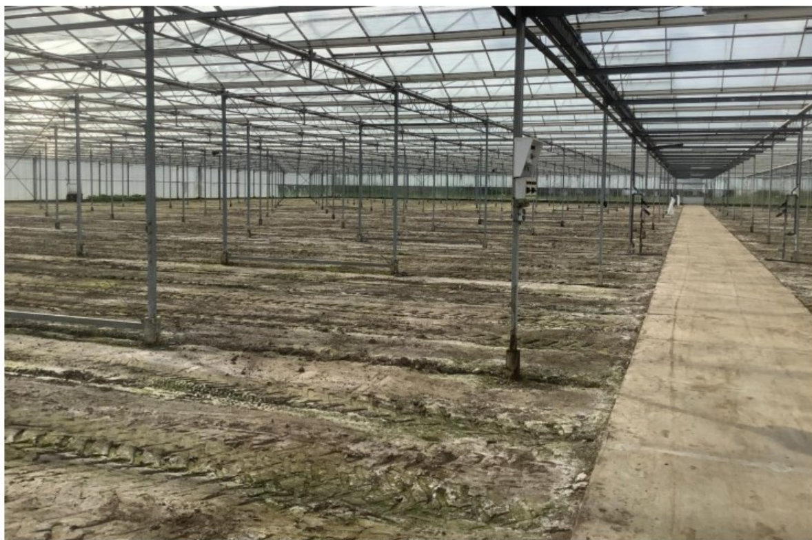
Foto van de binnenzijde van de kas – d.d. 1 mei 2023
