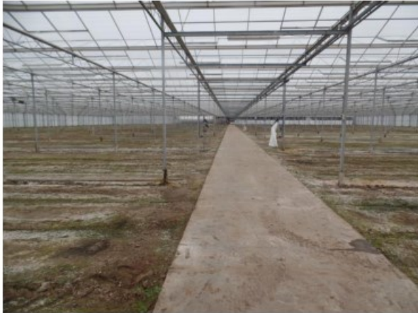
Het kassencomplex binnen
