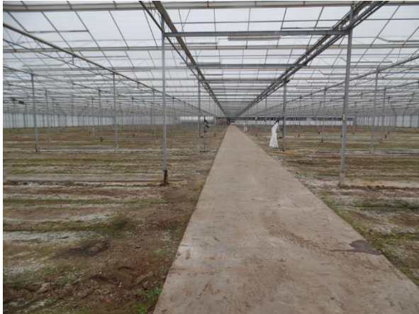
Het kassencomplex binnen
