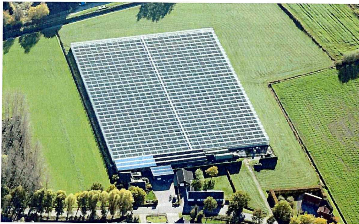
Figuur 1 Luchtfoto bestaande situatie (kijkende vanuit het noorden)
