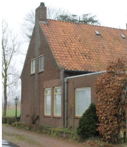
Rechterzijgevel met latere aanbouw
