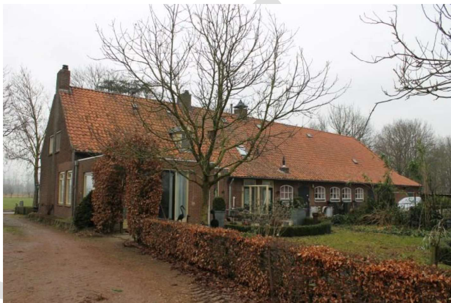
Achtergevel met links de latere aanbouw
