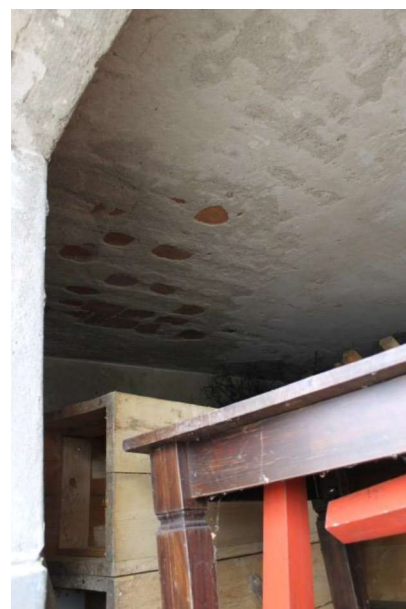
Onderzijde holle baksteen elementen paardenstal
