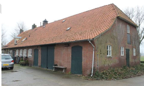
Oorspronkelijke achtergevel van het bedrijfsgebouwe
