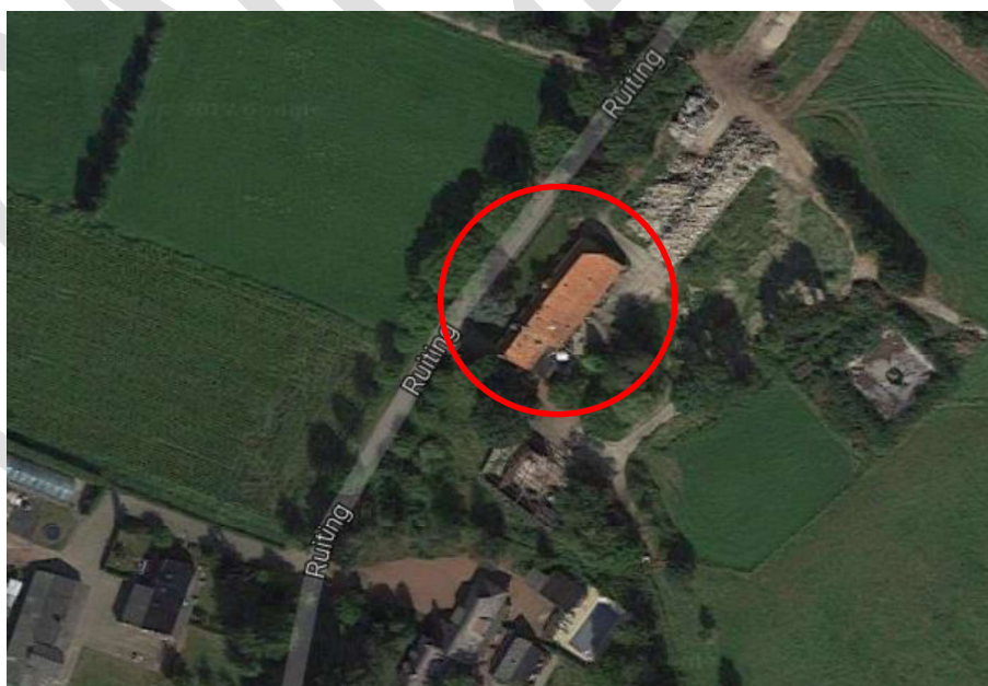
Een detailopname van de boerderij. Schuin naast de boerderij is de spantconstructie van de halfopen loods zichtbaar. Bron: Google Earth
