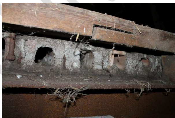
Holle bakstenen elementen van verdiepingsvloer
