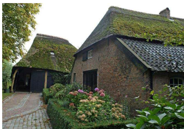
Zijdswarsdeelschuur met wanden van planken. De deeldeuren bevinden zich geheel links in de gevel.
