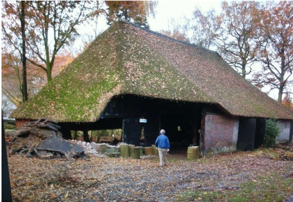
Schuur bij de demontage in Teteringen
