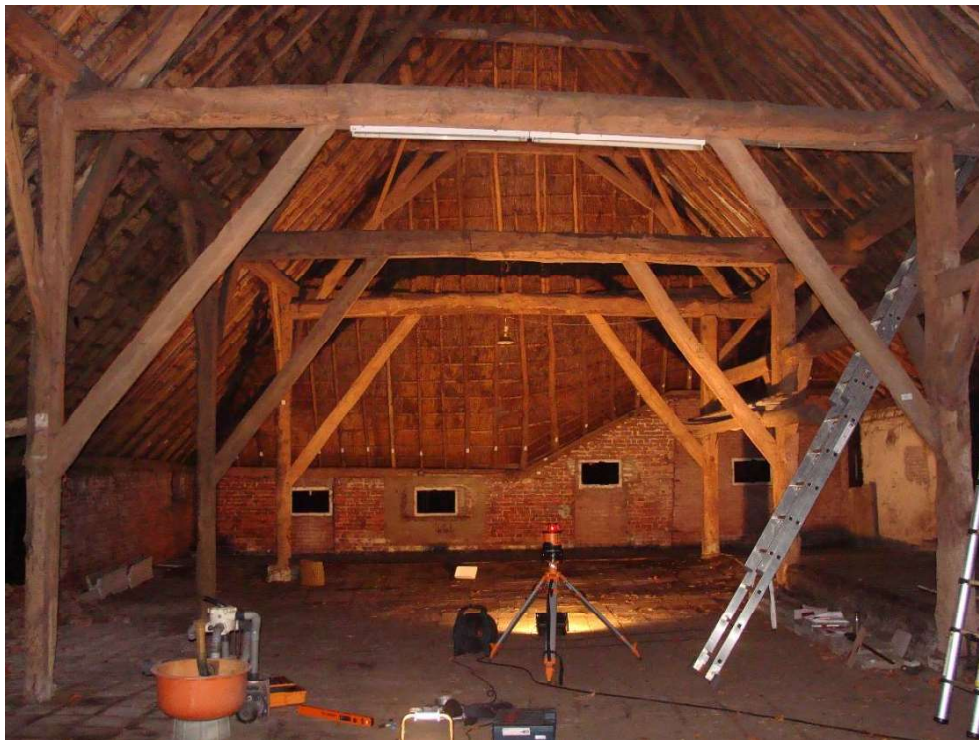
Interieur met drie van de vier gebinten. Geheel rechts, buiten de gebintstijlen, bevindt zich de deel.
