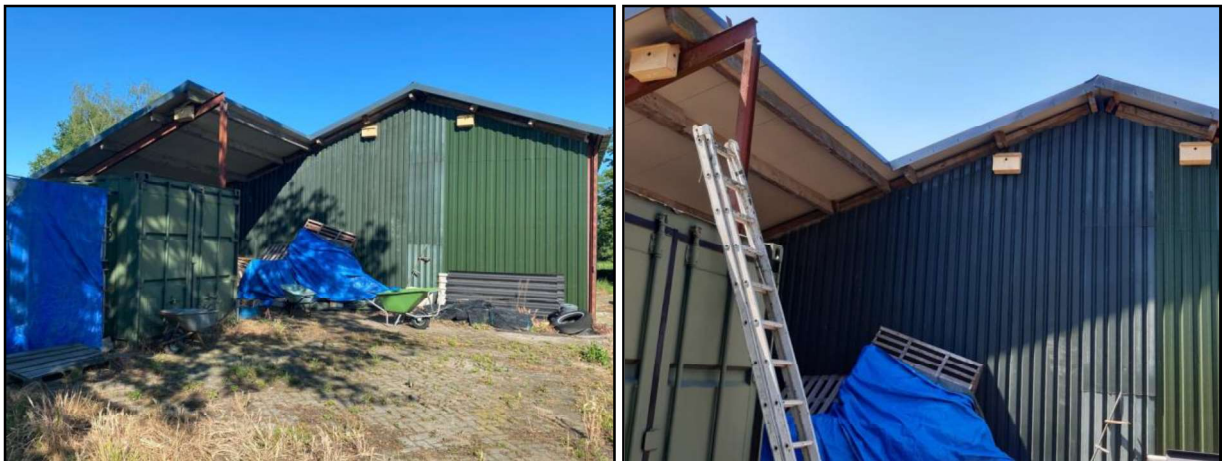
Figuur 2-3. De geplaatste alternatieve, tijdelijke koloniekasten tegen de gevel van de veldschuur.
