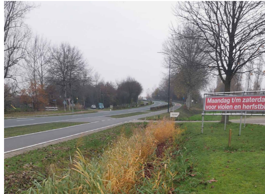
Figuur 11: Schijndelsedijk en viaduct over A2
