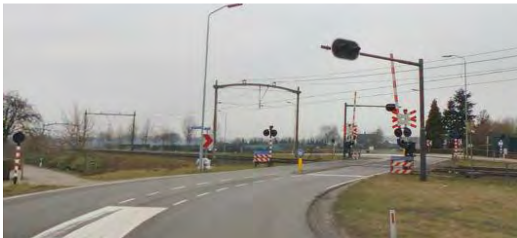
Figuur 3: Huidige overweg Kapelweg
