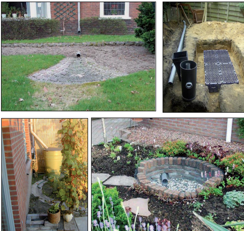
Figuur 18: Voorbeelden van infiltratiemogelijkheden
