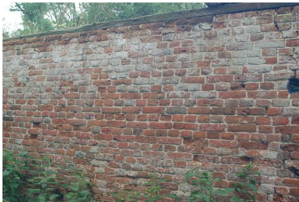
Muurwerk zijgevel in kruisverband.
