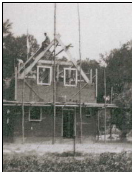
Klein Velder in aanbouw
