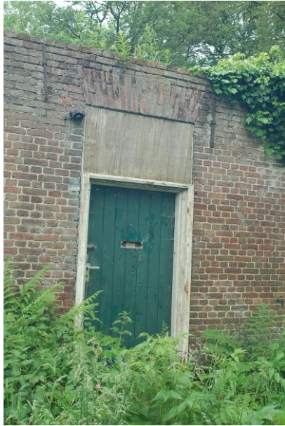
Links: voordeur met dichtgetimmerd bovenlicht. Rechts: gemetselde strek.
