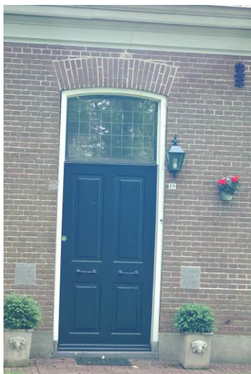
Voordeur en vensters met bovenlichten en gemetselde strekken.
