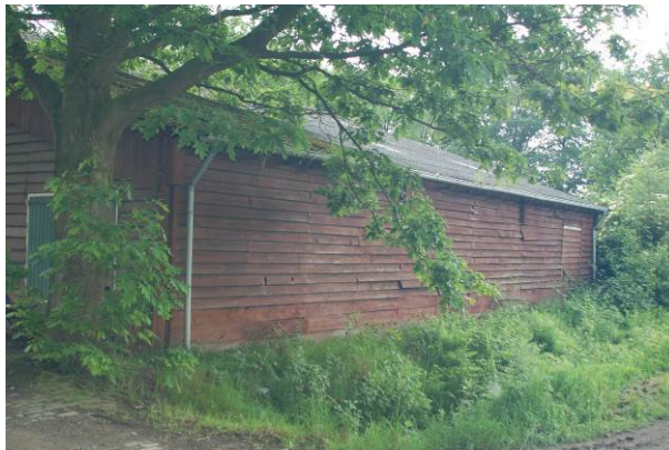
Zijgevel houten kapschuur
