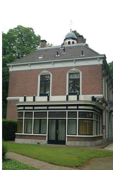
Serre tegen de zijgevel
