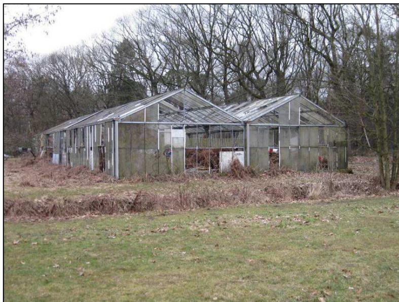
Figuur 1: Te saneren kassen op bouwblok op Landgoed Velder
