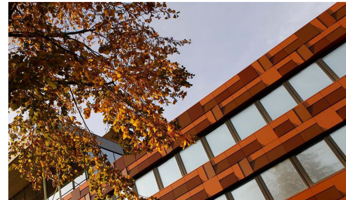
Solardesigngevel (Studio Solarix/Kameleon Solar, Kuijpers gebouw (Helmond))
