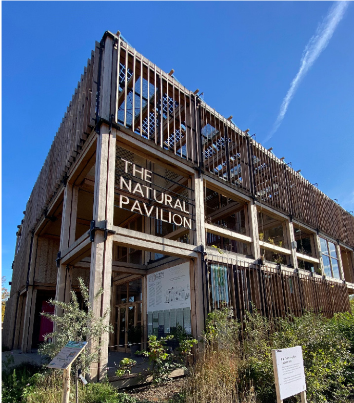
Duurzaam/circulair bouwen (houtskeletbouw; The Natural Pavilion, Floriade 2022 (Almere))
