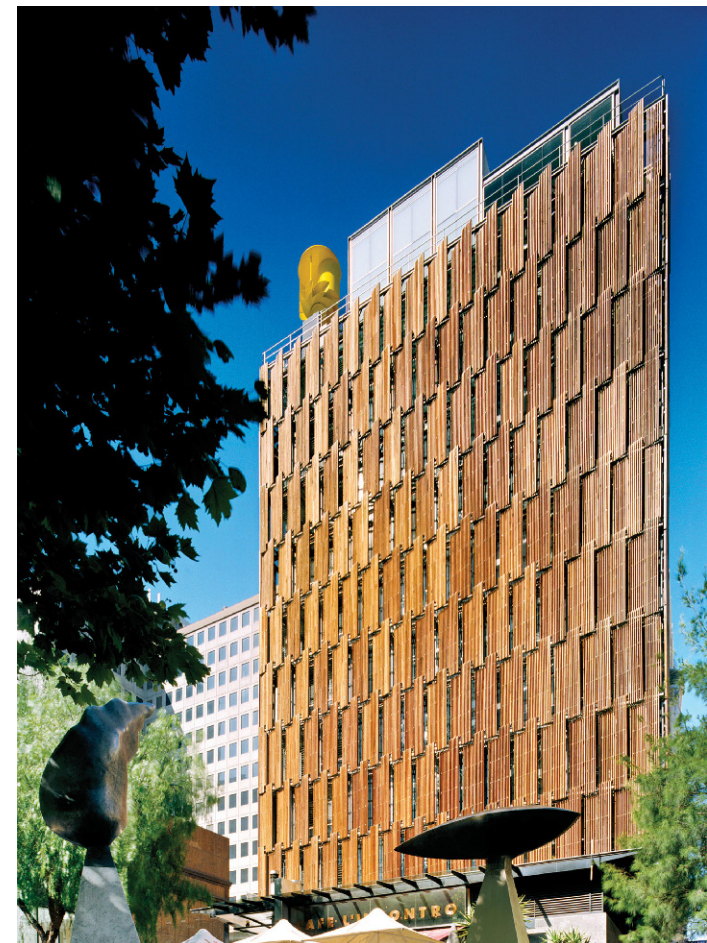
Biobased architectuur door nabootsing termietenheuvel in gevelsysteem dat verkoeling gebouw verzorgt
