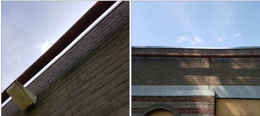
Figuur 2 Dakranden (links) en open stootvoegen met toegang tot de spouw (rechts).
