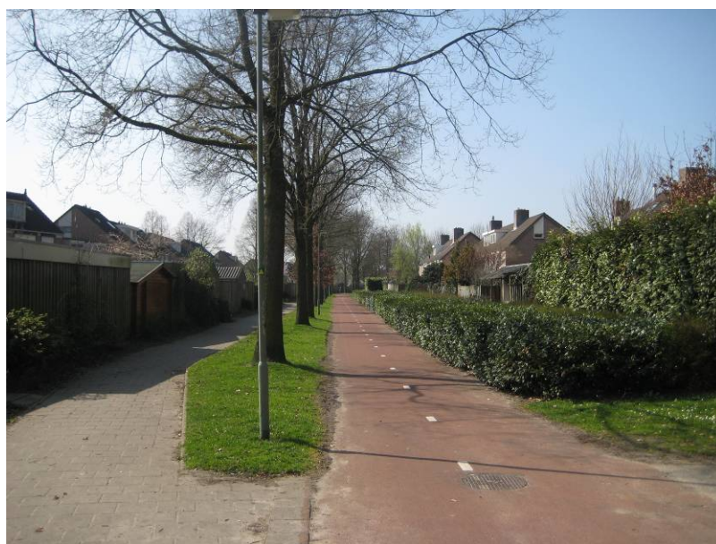
Vrijliggend fietspad door woongebied
